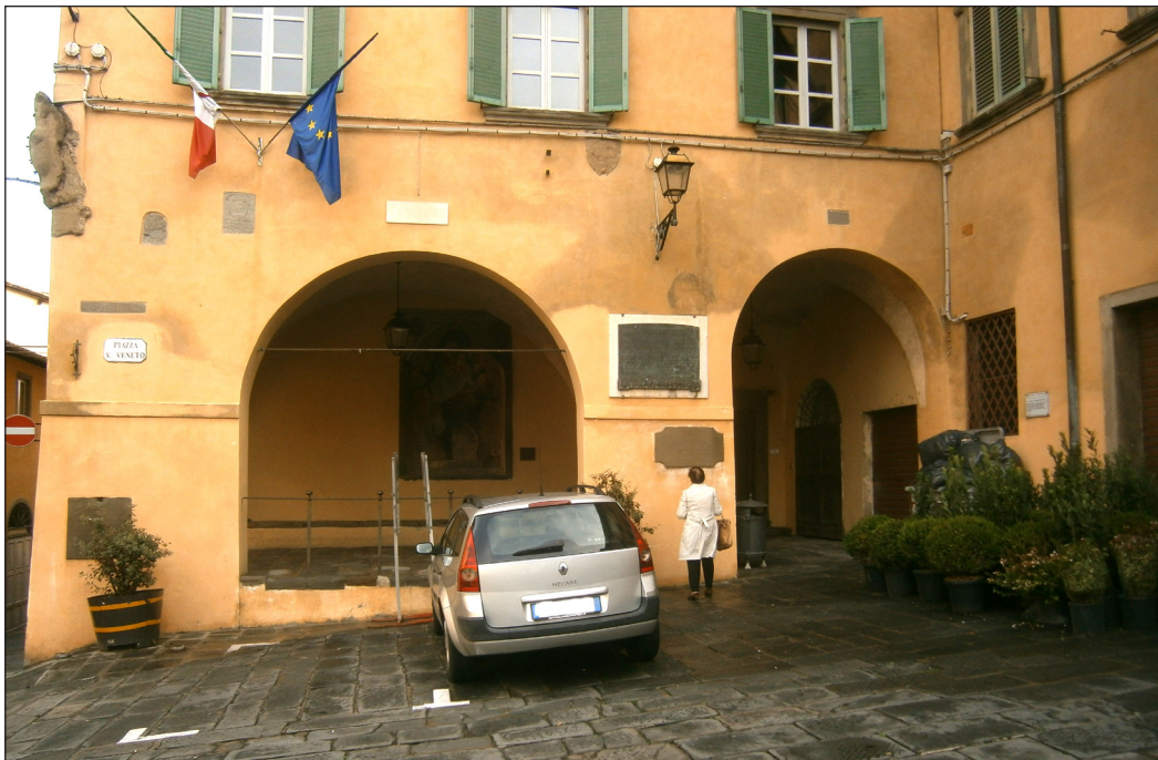
Particolare del palazzo pretorio con la lapide sovrastata da quella in bronzo del bollettino di guerra del 4 novembre 1918.
